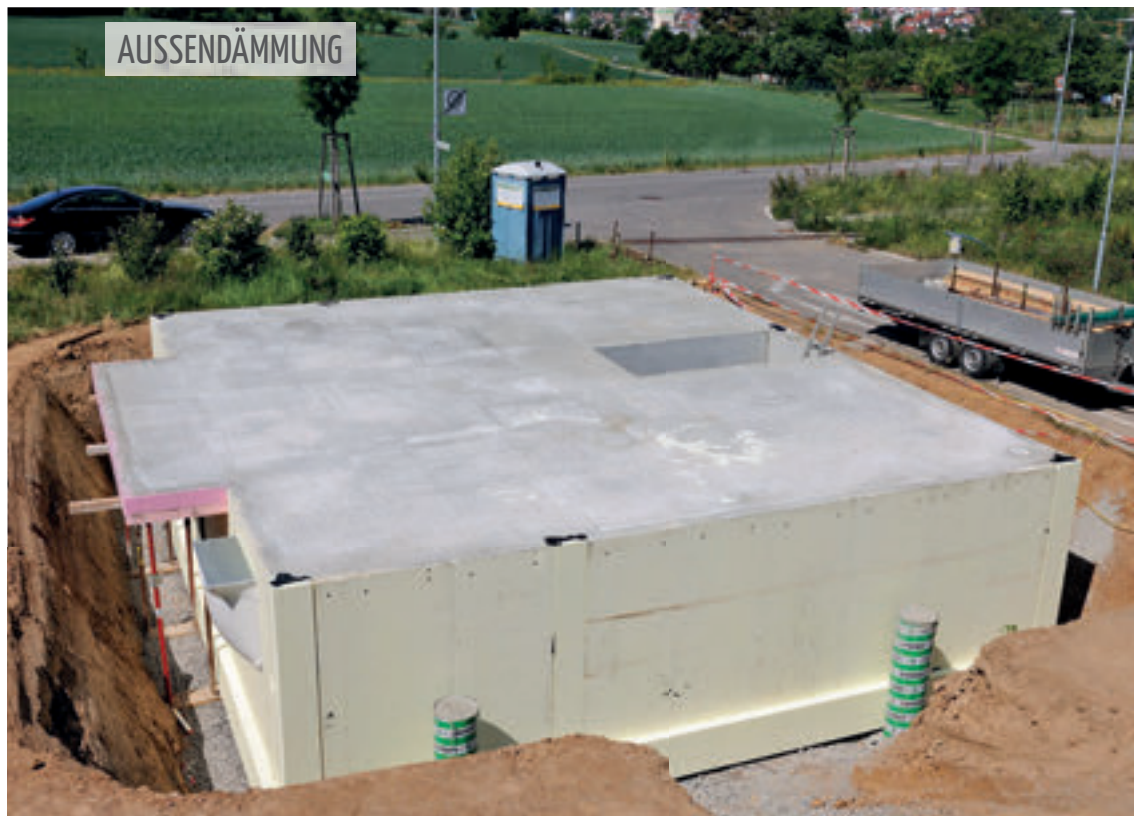
Die Außenwanddämmung garantiert maximalen Komfort im Untergeschoss. Selbst hohe Dämmdicken sind ohne Innenraumverlust möglich. Besonders hochwertig ist die KlimaPlus Wand von KNECHT – die Außendämmung wird bereits im Werk angebracht: Maßarbeit für den Keller.
