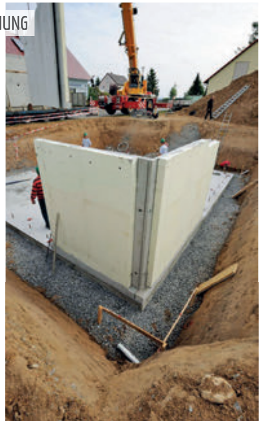
Die Außenwanddämmung garantiert maximalen Komfort im Untergeschoss. Selbst hohe Dämmdicken sind ohne Innenraumverlust möglich. Besonders hochwertig ist die KlimaPlus Wand von KNECHT – die Außendämmung wird bereits im Werk angebracht: Maßarbeit für den Keller.
