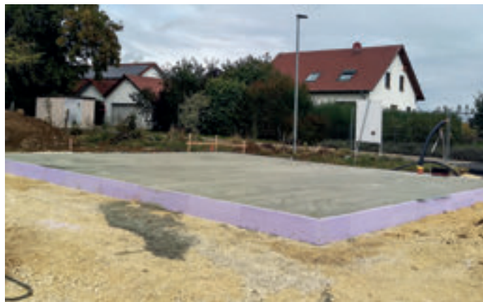
Die gedämmte Bodenplatte ist das tragende Fundament für das energieeffiziente Eigenheim. Wenn der Beton ausgehärtet ist, kann der Hausbau starten.
