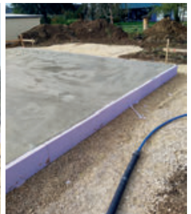
Die gedämmte Bodenplatte ist das tragende Fundament für das energieeffiziente Eigenheim. Wenn der Beton ausgehärtet ist, kann der Hausbau starten.
