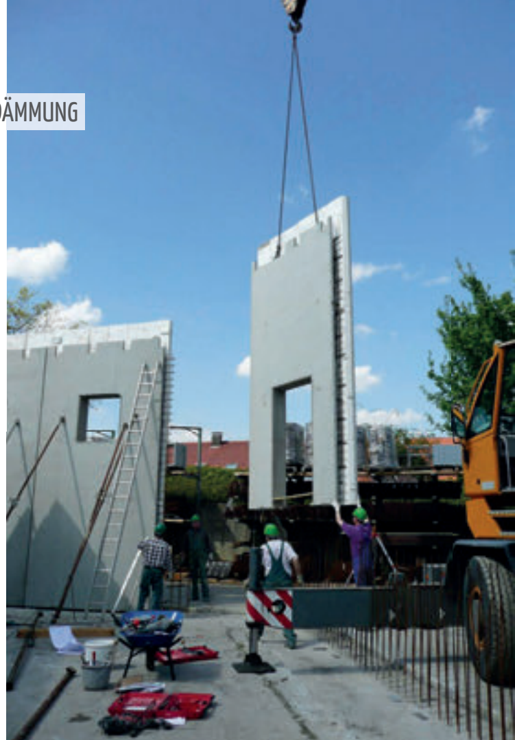
Die Kerndämmung kommt ohne Außenputz aus.
