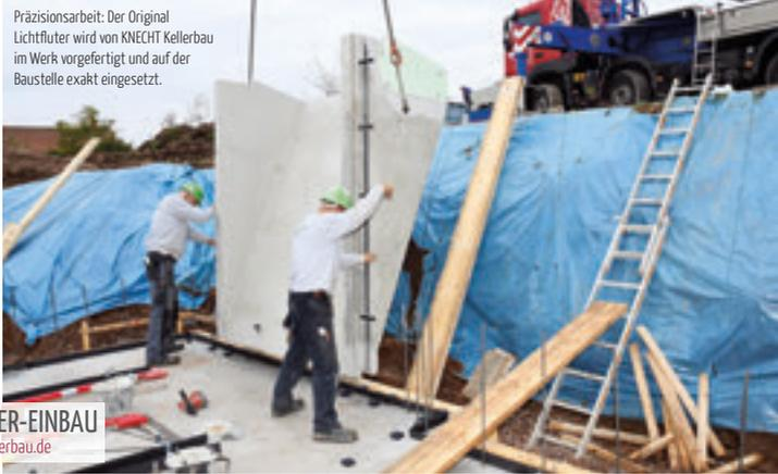
Präzisionsarbeit: Der Original Lichtfluter wird von KNECHT Kellerbau im Werk vorgefertigt und auf der Baustelle exakt eingesetzt.
