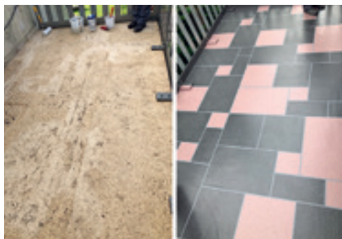
In einem Wohnhaus bekam ein Holzbalkon mit Spanplatten eine neue Grundierung und das Creative Design mit zwei verschiedenen Fliesenfarben und andersfarbiger Fuge.
