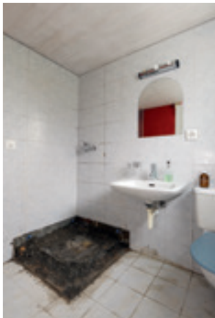
Im ersten Schritt musste die bestehende Duschkabine und die stahl-emaillierte Duschwanne demontiert und entsorgt werden.
