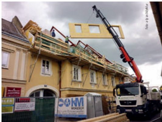
Der Dachraum vor dem Umbau lässt kaum erahnen, welch attraktiver Wohnraum hier neu entstehen wird.
