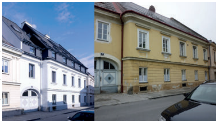
Beim Umbau des Winzerhauses gelang es, die bestehende Fassade möglichst unverändert zu bewahren, gleichzeitig aber den Altbau energetisch zu sanieren und behutsam zu ergänzen. Trotz optisch deutlicher Aufwertung und Modernisierung fügt es sich durch das Satteldach weiter harmonisch in den engen Straßenzug ein, der von meist zweigeschossigen Altbauten gesäumt ist.
