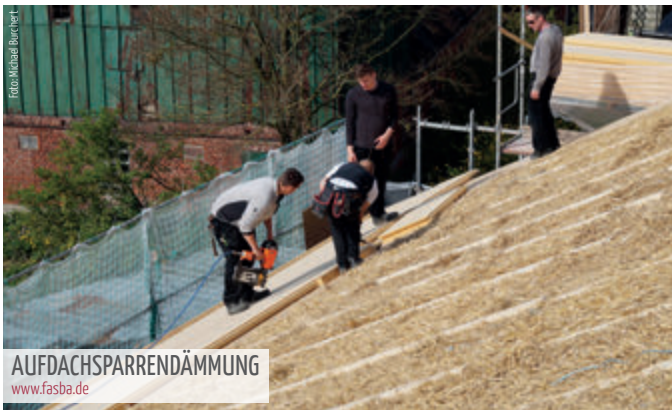
EINBAU VON BAUSTROHBALLEN www.fasba.de
