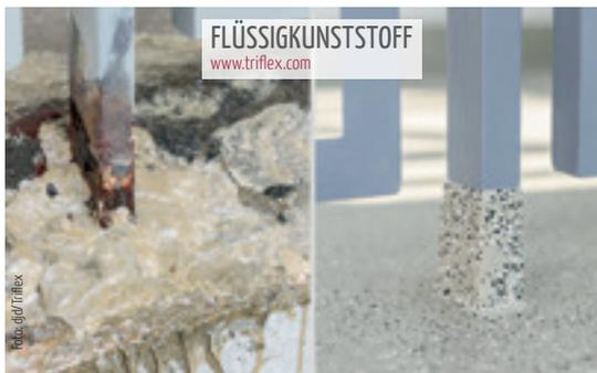
Bei einem nicht akkurat abgedichteten Balkongeländer droht das Eindringen von Feuchtigkeit (links). Mit Flüssigkunststoff lassen sich Details und Übergänge unterschiedlicher Materialien langzeitsicher abdichten (rechts).
