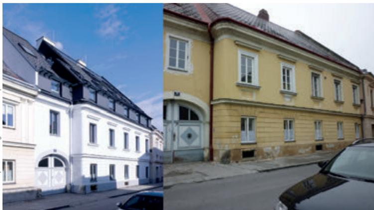
Beim Umbau des Winzerhauses gelang es, die bestehende Fassade möglichst unverändert zu bewahren, gleichzeitig aber den Altbau energetisch zu sanieren und behutsam zu ergänzen. Trotz optisch deutlicher Aufwertung und Modernisierung fügt es sich durch das Satteldach weiter harmonisch in den engen Straßenzug ein, der von meist zweigeschossigen Altbauten gesäumt ist.
